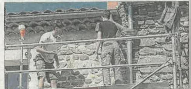
**Les élèves ont posé des pierres de parements sur les façades d'une maison avec du mortier.**
