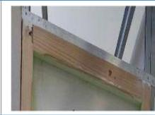
L'imposte qui est au-dessus de la porte est constituée de rails et de montants, cela permet de renforcer la plaque plâtre.
