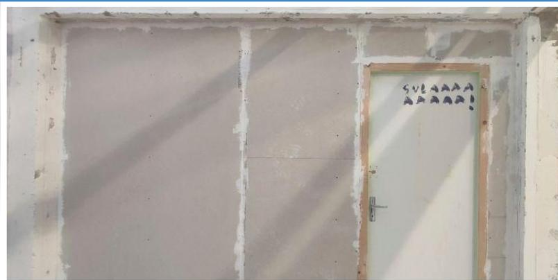
Rebouchage des trous avec du MAP (mortier adhésif pour plaque de plâtre)
