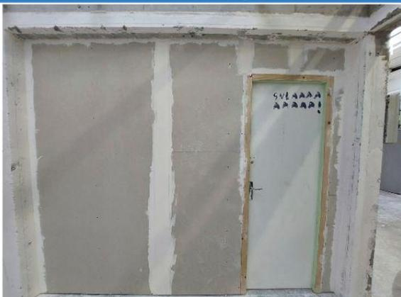
Voici le rendu final, il manquera juste deux passes d'enduit sur les bandes à joint et le mastic acrylique entre le sol et la plaque de plâtre. Puis le peintre reprendra la suite du travail.
